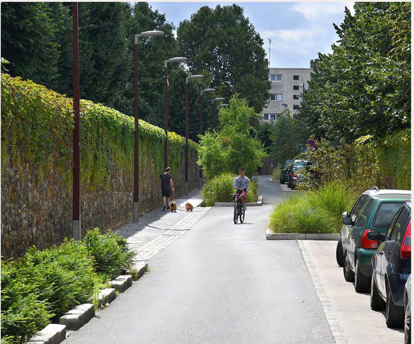
La chaussée a un profil en toit et les eaux pluviales sont dirigées dans les fosses de plantations où elles peuvent entrer grâce à des passages d'eau créés dans les bordures. Aménagement finalisé, rue Sœur Valérie, Asnières-sur-Seine (92).
