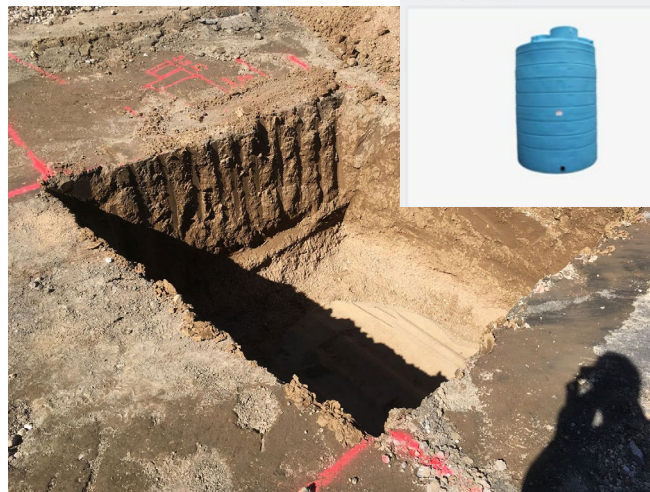
Fosse pour Cuve de 15 000 litres enterrée dans le sol pour arroser les plantes de la cour
